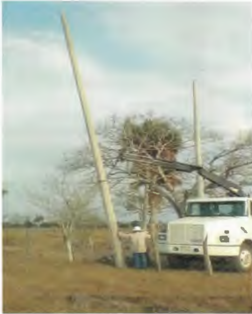
SUMINISTRO E INSTALACION DE POSTE DE CONCRETO DE 12760, INCLUYE RELLENO DE CEPAL CON PIEDRA CALIZA.
