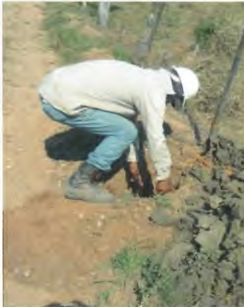
EXCAVACION MANUAL DE CEPA PARA POSTES DE CONCRETO EN TERRENO MIXTO.
