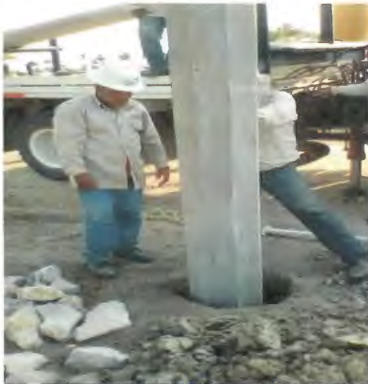
SUMINISTRO E INSTALACION DE POSTE DE CONCRETO DE 12760, INCLUYE RELLENO DE CEPAL CON PIEDRA CALIZA.
