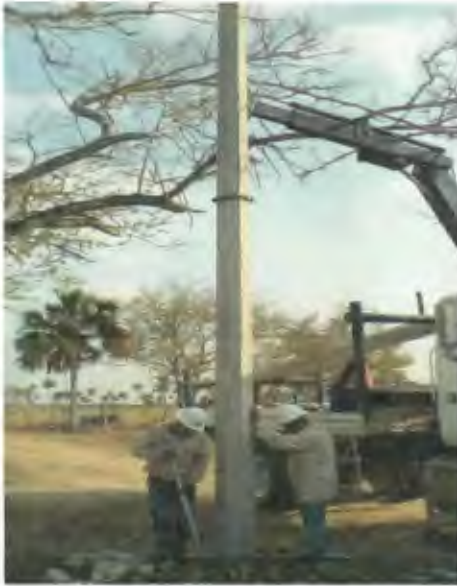
SUMINISTRO E INSTALACION DE POSTE DE CONCRETO DE 12750, INCLUYE RELLENO DE CEPAL CON PIEDRA CALIZA.
