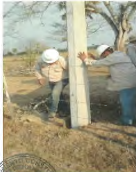
SUMINISTRO E INSTALACION DE POSTE DE CONCRETO DE 12750, INCLUYE RELLENO DE CEPAL CON PIEDRA CALIZA.
