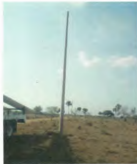
SUMINISTRO E INSTALACION DE POSTE DE CONCRETO DE 12750, INCLUYE RELLENO DE CEPAL CON PIEDRA CALIZA.
