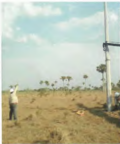
SUMINISTRO E INSTALACION DE POSTE DE CONCRETO DE 12750, INCLUYE RELLENO DE CEPAL CON PIEDRA CALIZA.
