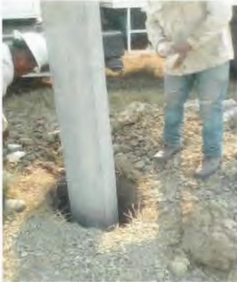
SUMINISTRO E INSTALACION DE POSTE DE CONCRETO DE 12750, INCLUYE RELLENO DE CEPAL CON PIEDRA CALIZA.
