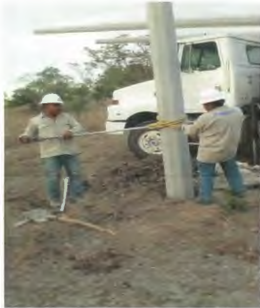
SUMINISTRO E INSTALACION DE POSTE DE CONCRETO DE 12760, INCLUYE RELLENO DE CEPAL CON PIEDRA CALIZA.
