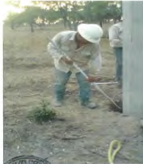
SUMINISTRO E INSTALACION DE POSTE DE CONCRETO DE 12760, INCLUYE RELLENO DE CEPAL CON PIEDRA CALIZA.
