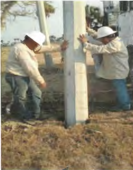
SUMINISTRO E INSTALACION DE POSTE DE CONCRETO DE 12750, INCLUYE RELLENO DE CEPAL CON PIEDRA CALIZA.
