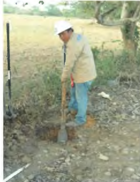
EXCAVACION MANUAL DE CEPA PARA POSTES DE CONCRETO EN TERRENO MIXTO.
