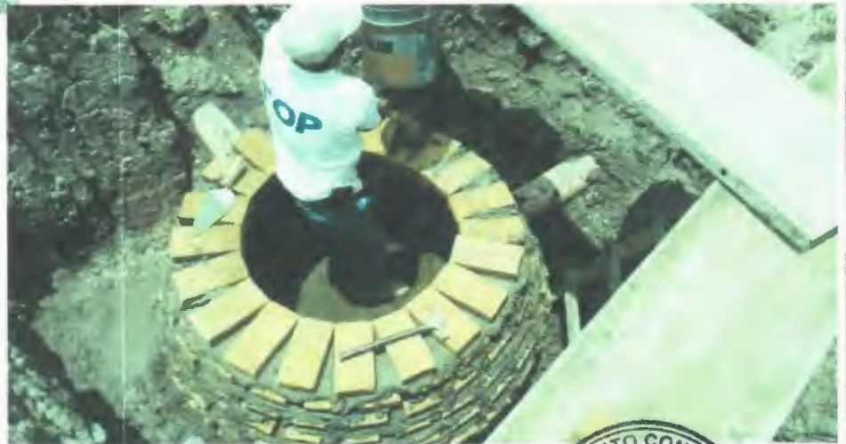
POZO DE VISITA CONICO CON BASE DE 120 Y BOCA DE 60 CM., CON 2.00 M DE PROFUNDIDAD
