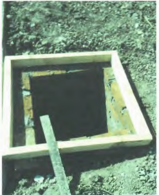
SUMINISTRO E INSTALACION DE DESCARGA DOMICILIARIA DE DRENAJE SANITARIO
