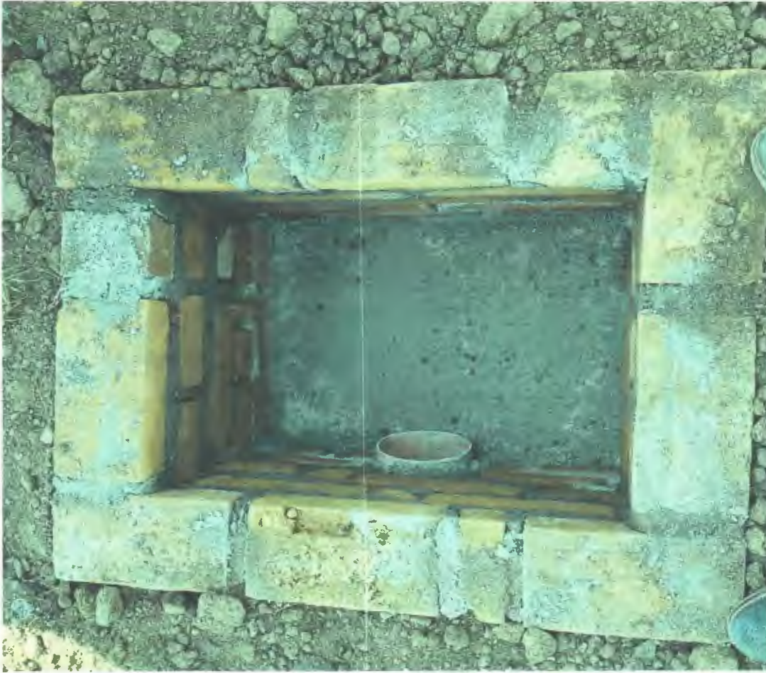
SUMINISTRO E INSTALACION DE DESCARGA DOMICILIARIA DE DRENAJE SANITARIO
