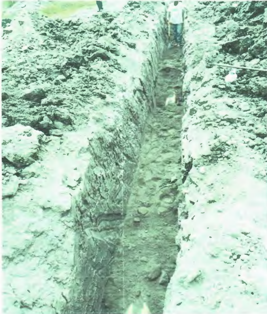
RELLENO EN CEPAS CON MATERIAL DE BANCO
