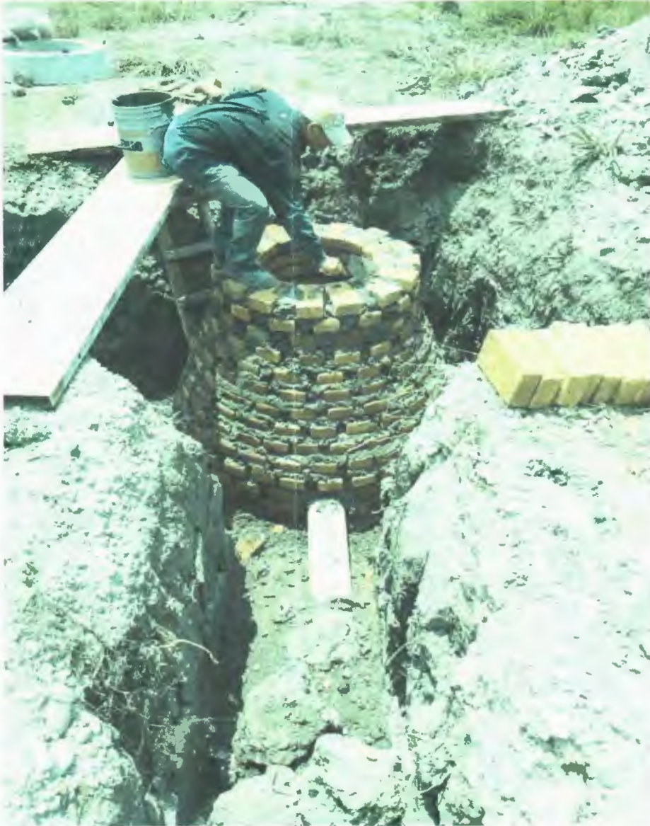
POZO DE VISITA CONICO CON BASE DE 120 Y BOCA DE 60 CM., CON 2.00 M DE PROFUNDIDAD
