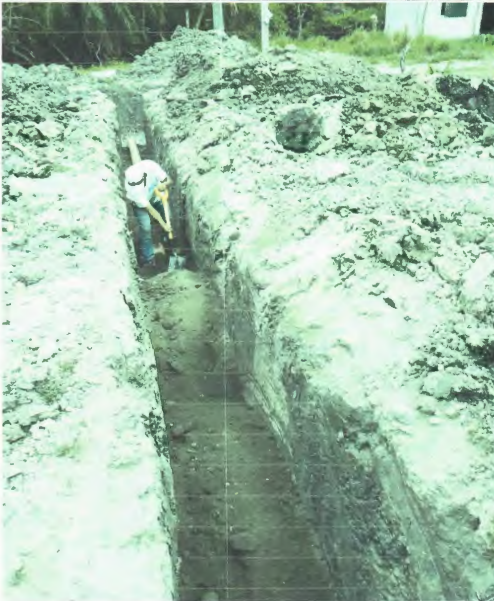
RELLENO EN CEPAS CON MATERIAL DE BANCO
