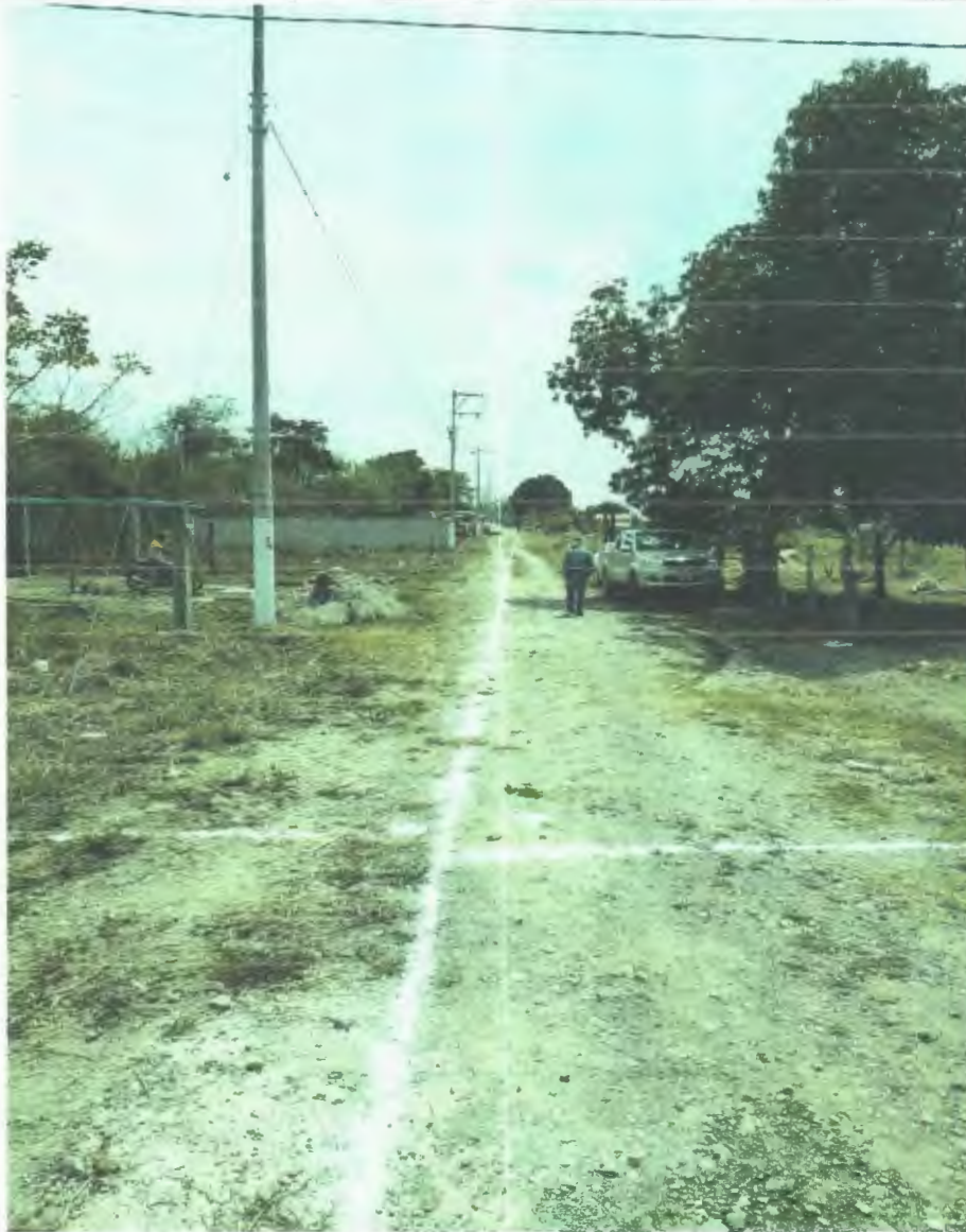
TRAZO Y NIVELACION TOPOGRAFICA DE TERRENO
