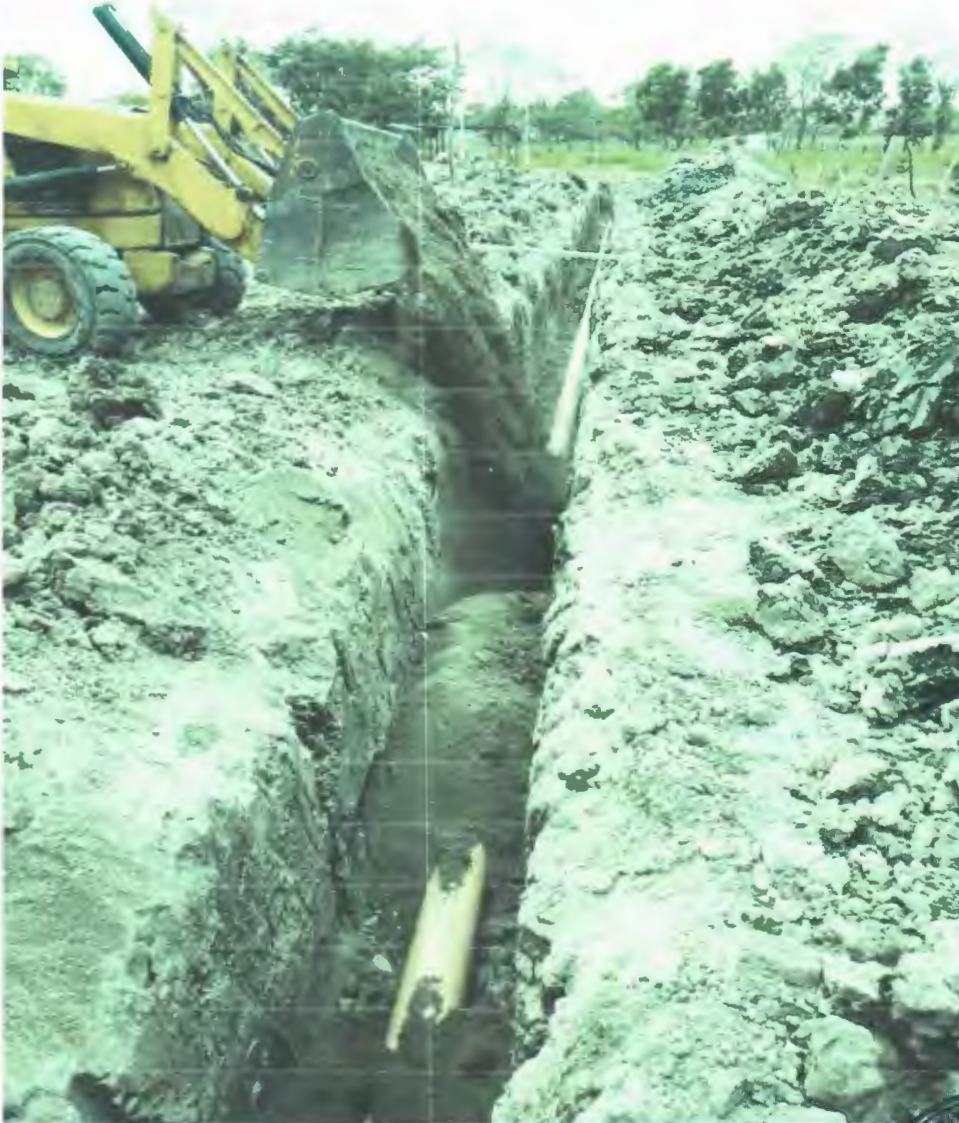
CAMA DE ARENA APISONADA MANUALMENTE EN CEPAS PARA DAR APOYO UNIFORME
