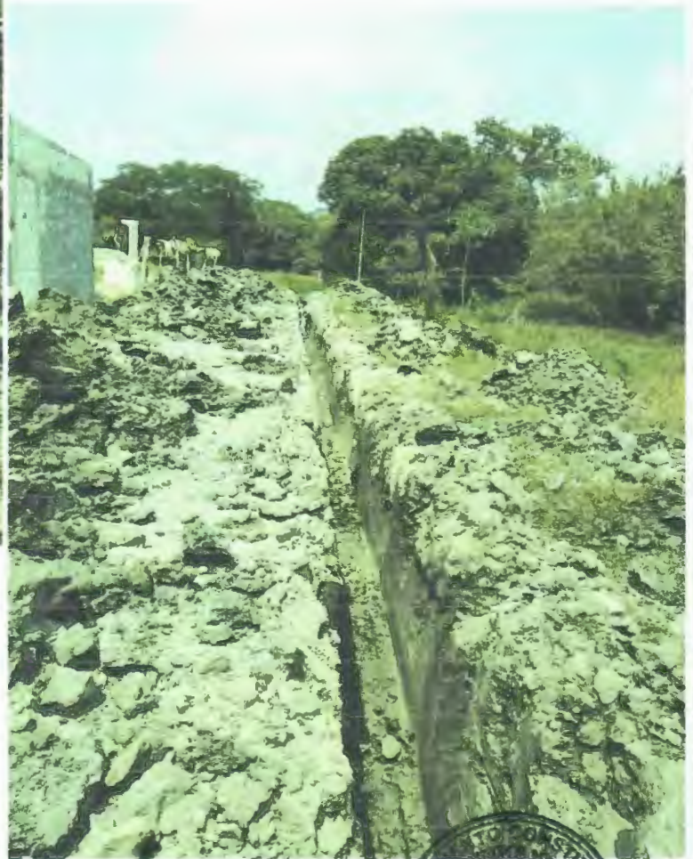
EXCAVACION EN ZANJA, CON RETROEXCAVADORA
