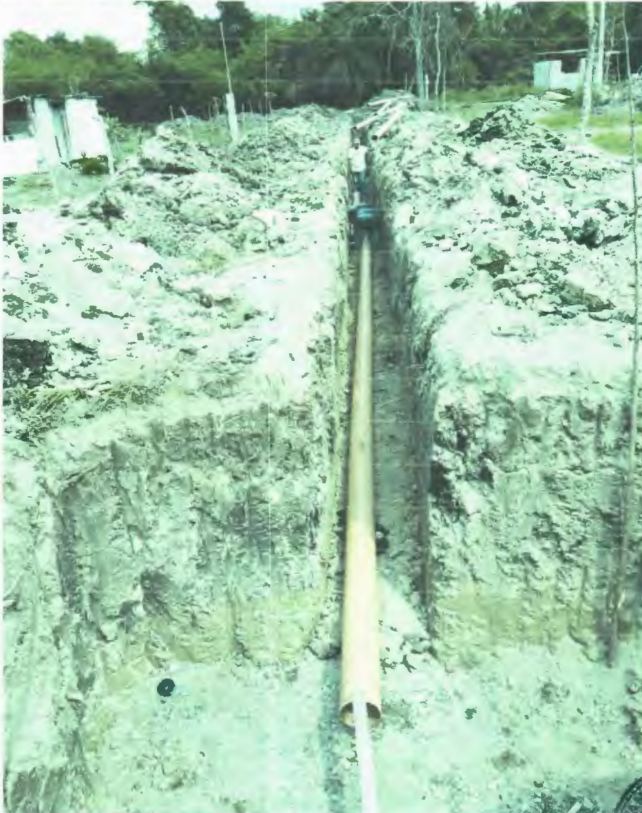
SU MINISTRO Y COLOCACION DE TUBO DE PVC ALCANTARILLADO SERIE 25 DE 200 mm (8") DE DIAMET
