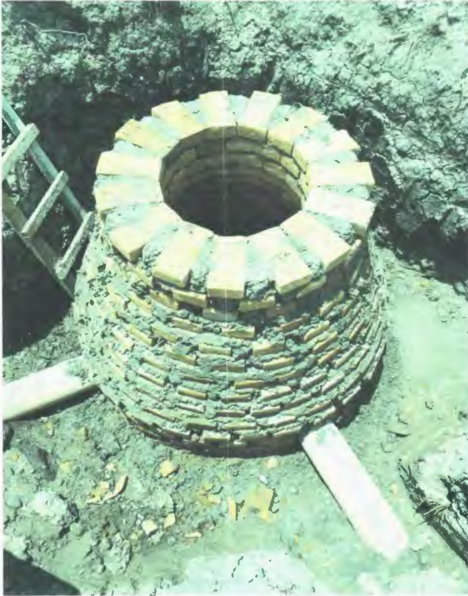
POZO DE VISITA CONICO CON BASE DE 120 Y BOCA DE 60 CM., CON 3.00 M DE PROFUNDIDAD
