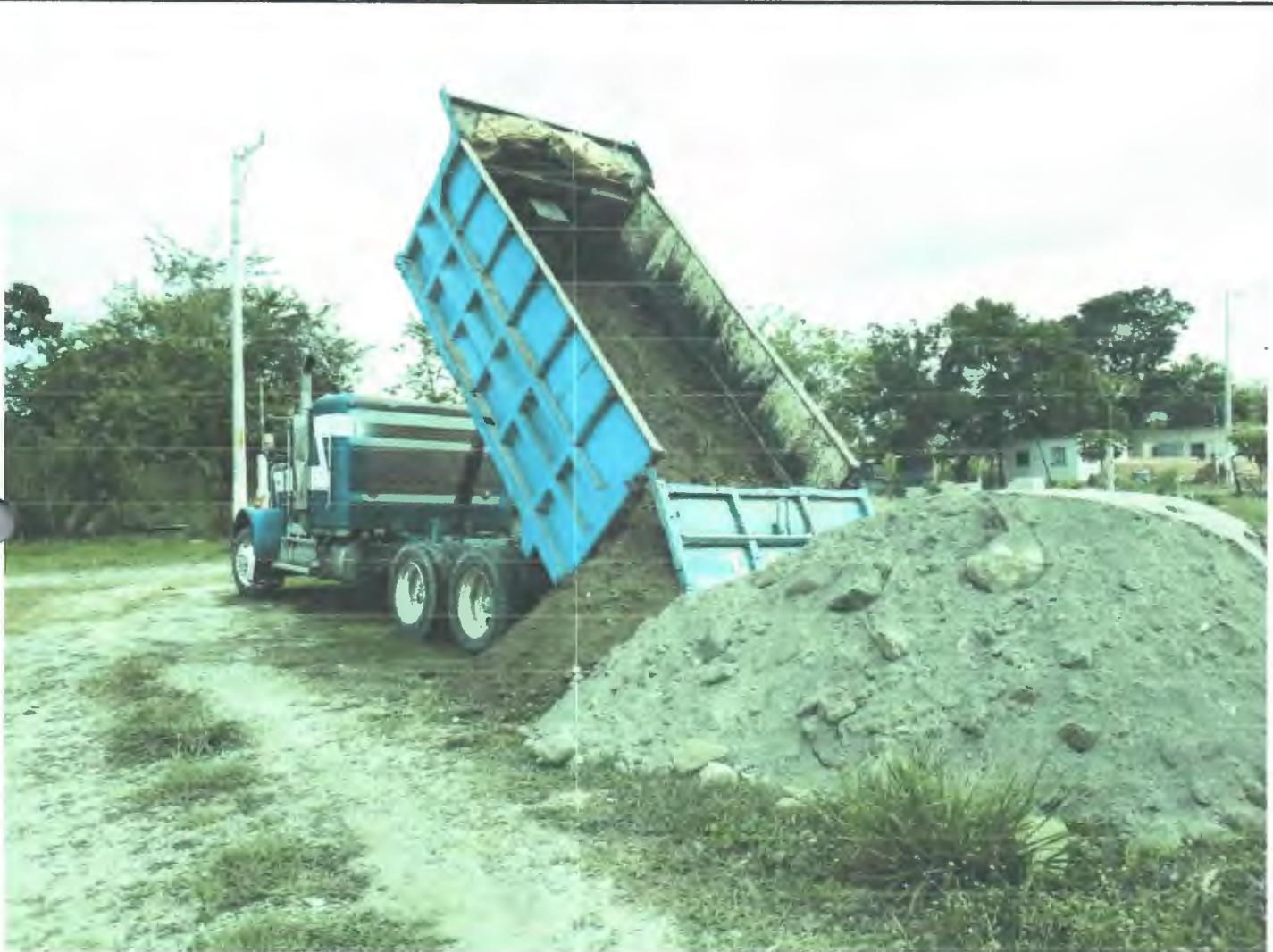
RELLENO EN CEPAS CON MATERIAL DE BANCO
