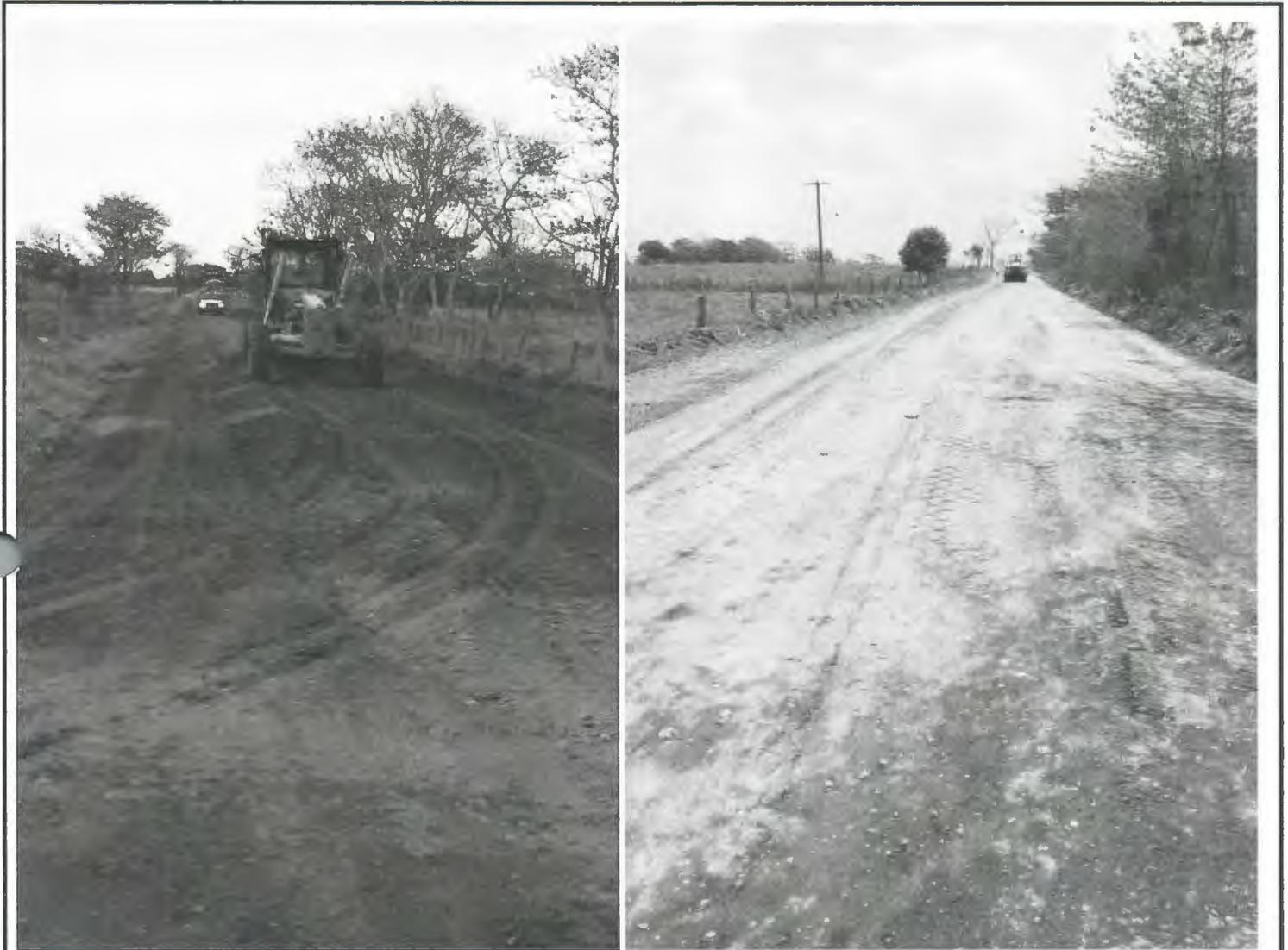
OPERACIÓN DE TENDIDO, CONFORMACION Y AFINAMIENTO PARA DAR ACABADO AL MATERIAL DE REVESTIMIENTO. INCLUYE: COMPACTACION CON MAQUINARIA, MANO DE OBRA, HERRAMIENTA Y EQUIPO NECESARIO.
