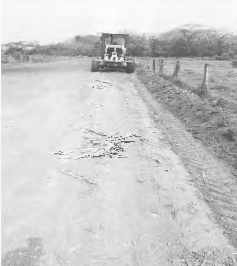
CUNETEO CON MAQUINARIA DEPOSITANDO EL MATERIAL A LOS COSTADOS DEL TRAMO POR REHABILITAR. INCLUYE: MANO DE OBRA, HERRAMIENTA Y EQUIPO NECESARIO.
