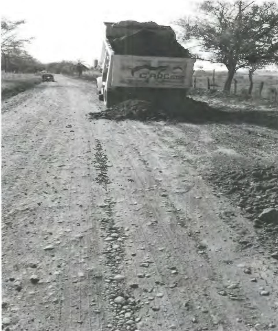
ACARREO EN CAMION 1 er. KILOMETRO DE MATERIAL MIXTO EN CAMINO LOMERIO, SUAVE, BRECHA, TERRACERIA PRONUNCIADA, MONTAÑOSO REVESTIDO. INCLUYE: CARGA CON EQUIPO MECANICO.
