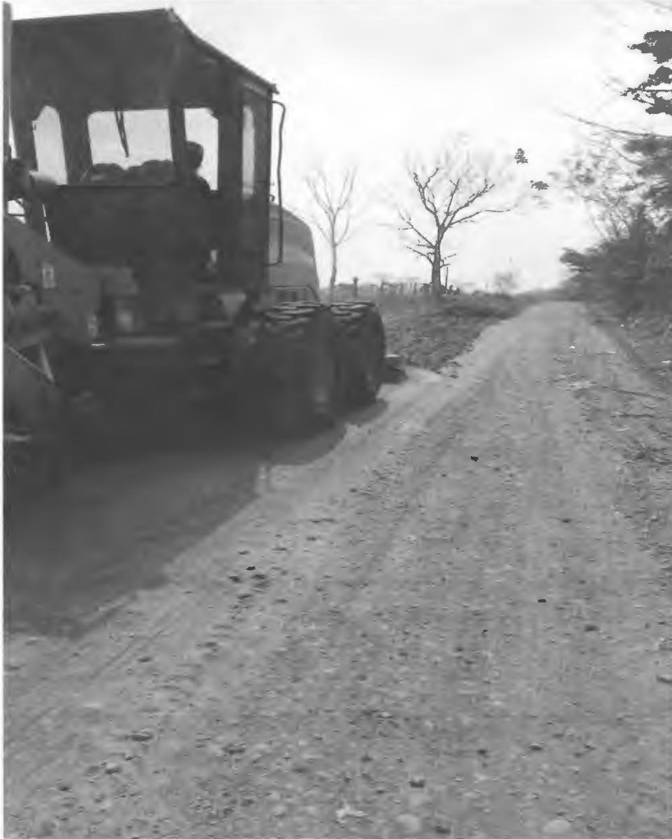
ESCARIFICADO, DISGREGADO Y ACAMELLONADO DEL MATERIAL PRODUCTO DEL CORTE EN SUPERFICIES DE RODAMIENTO. INCLUYE: MANO DE OBRA, HERRAMIENTA Y EQUIPO).
