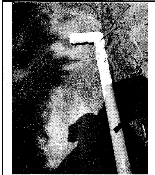
No. De obra: 2018301740040 Contrato: MTB-FISM-DF-DOP-2018301740001 CONSTRUCCION DE SISTEMA DE AGUA POTABLE EL ROBLE Supervisor: Arq Ricardo E. Vela Rodriguez
