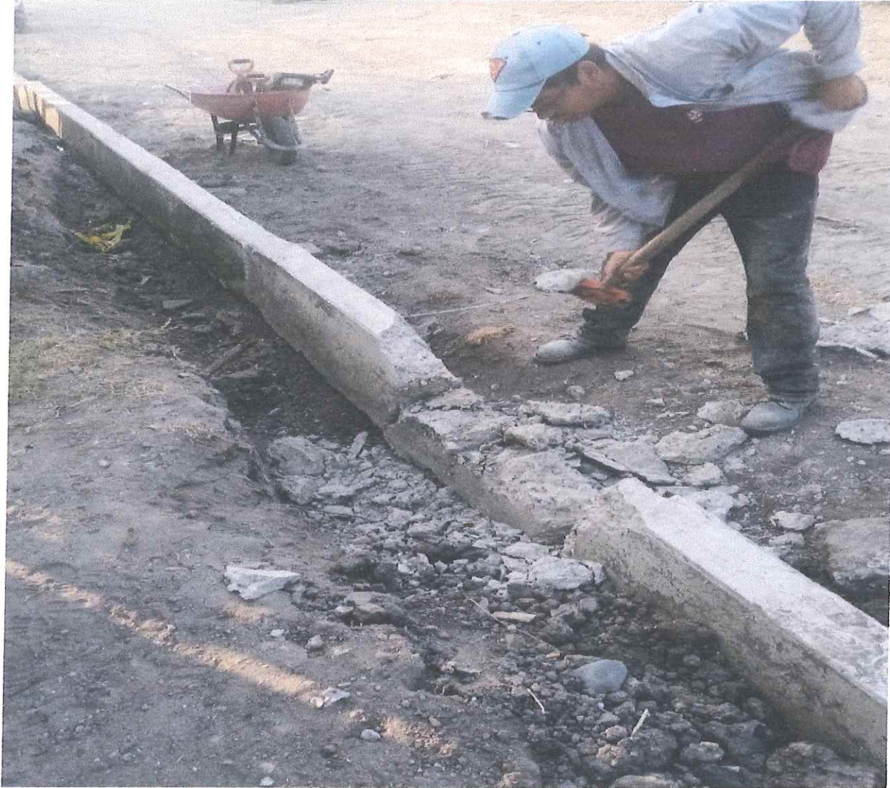
DEMOLICION A MANO DE GUARNICIONES DE CONCRETO SIMPLE DE SECCION 15X20X40 INCLUYE APILE DE MATERIAL.
