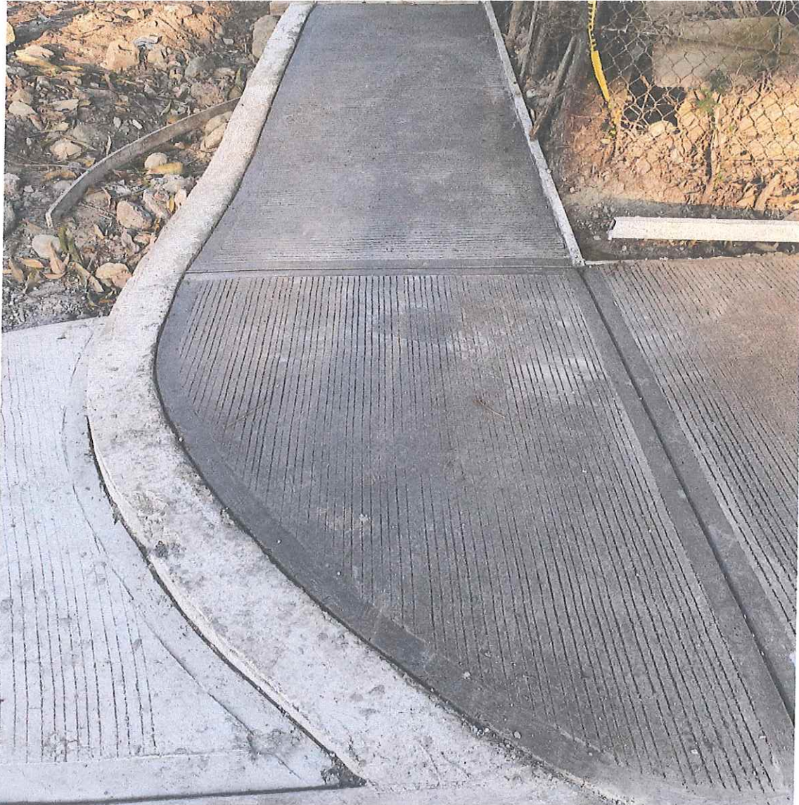
CONSTRUCCIÓN DE RAMPAS PARA DISCAPITADOS CON UNA PENDIENTE MÁXIMA DE 5% DE CONCRETO SIMPLE CON TEXTURA ANTIDERRAPANTE CON UN ANCHO DE 1.20 M.
