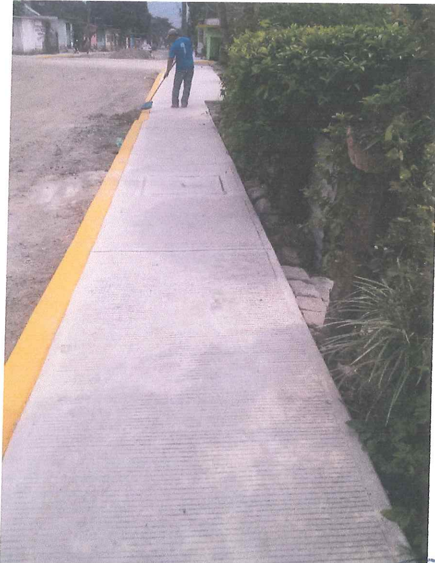
LIMPIEZA GRUESA AL FINAL DE LA OBRA INCLUYE ACARREOS Y RETIRO DE MATERIALES EXISTENTES
