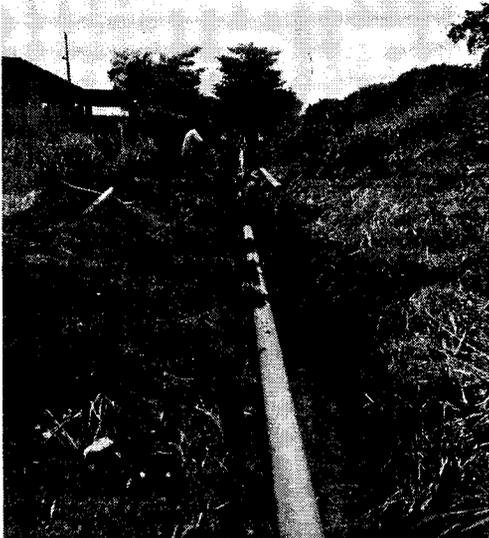
EXCAVACION DE ZANJA Y COLOCACION DE TUBO DE 8 " DE DIAMETRO
