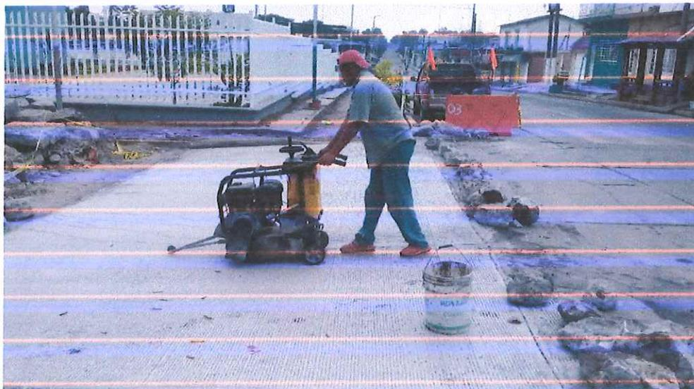
2.00 CORTE CON CORTADORA DE DISCO DE DIAMANTE EN SENTIDO LONGITUDINAL Y TRANSVERSAL.
