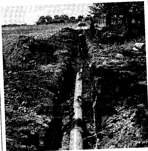
COLOCACION DE TUBO Y NIVELADO DE TUBO DE 8" DE DIAMETRO
