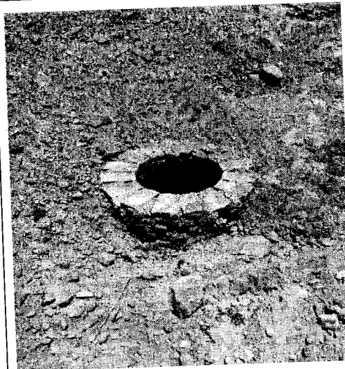
CONSTRUCCION DE POZO DE VISITA
