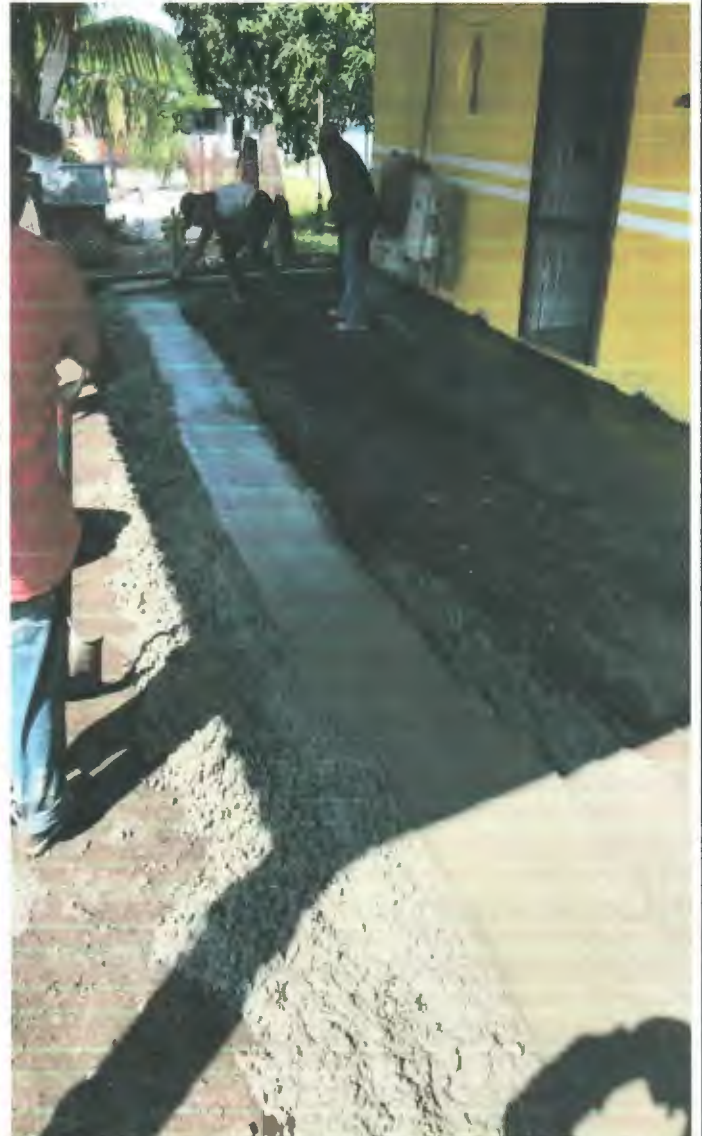
COLADO DE PISO DE 8 CM. DE ESPESOR DE CONCRETO HECHO EN OBRA F'C=150 KG/CM2, AGREGADO MAXIMO 3/4" DE DIAMETRO CONTROLADO
