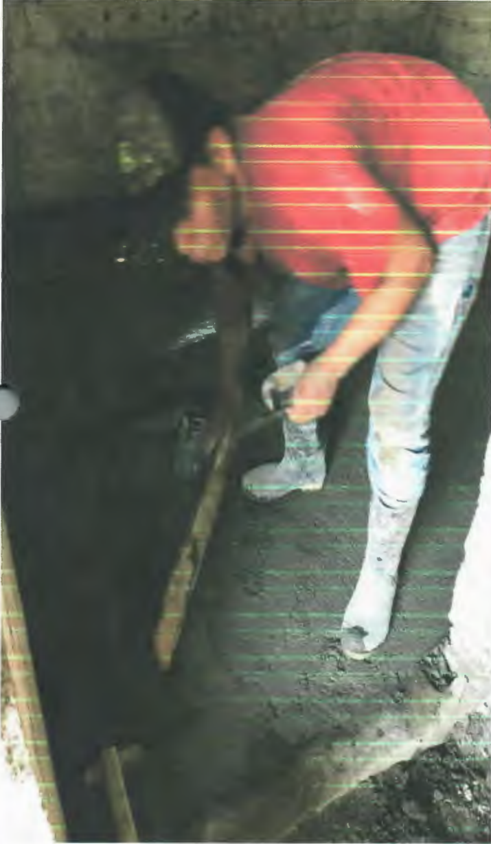
COLADO DE PISO DE 8 CM. DE ESPESOR DE CONCRETO HECHO EN OBRA F'C=150 KG/CM2, AGREGADO MAXIMO 6% DE FIBRAS DE POLIPROPILENO SEMIPULIDO
