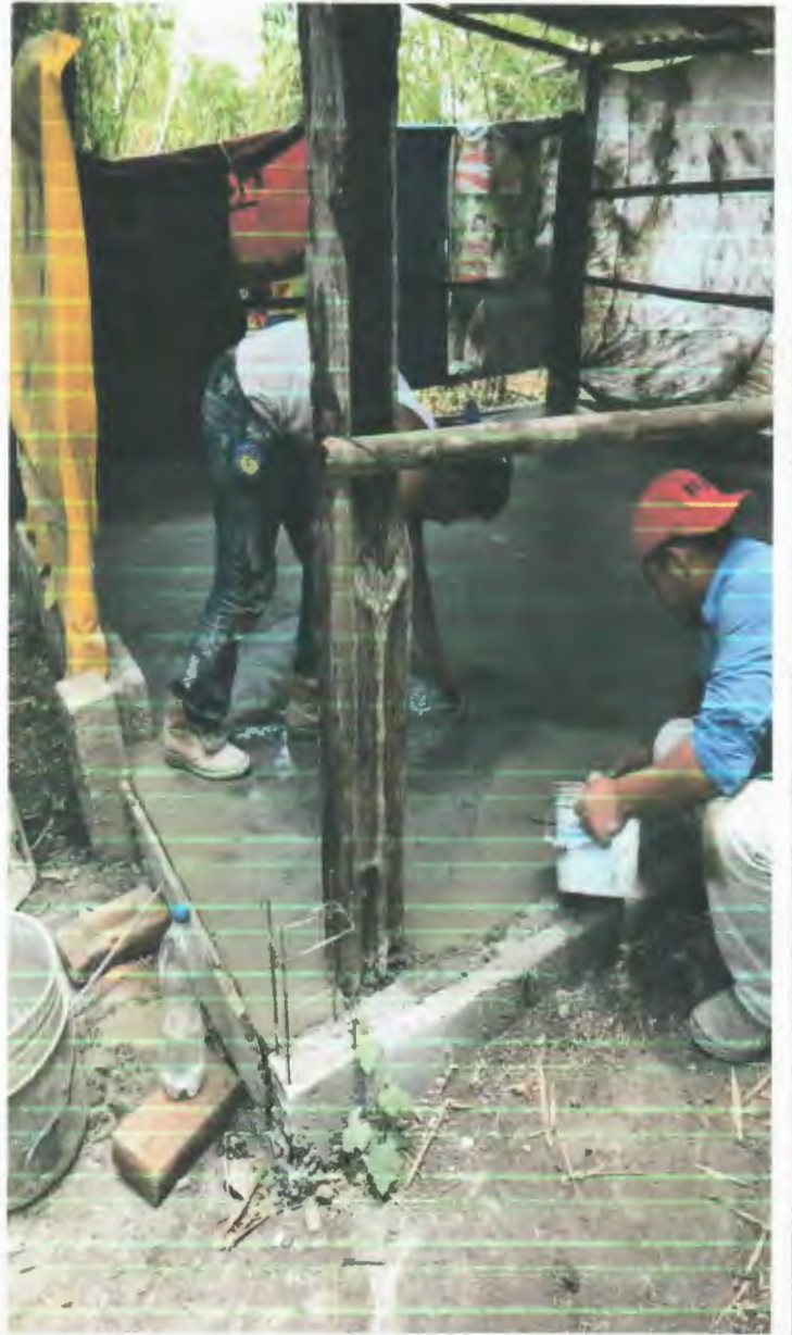
COLADO DE PISO DE 8 CM. DE ESPESOR DE CONCRETO HECHO EN OBRA F'C=150 KG/CM2, AGREGADO MAXIMO 6% DE FIBRAS DE POLIPROPILENO SEMIPULIDO
