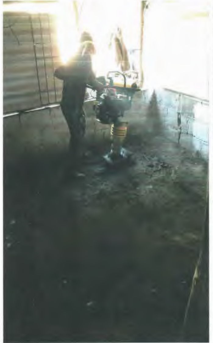
RELLENO COMPACTADO CON PISON DE MANO EN CAPAS DE 20CM. UTILIZANDO MATERIAL DE BANCO
