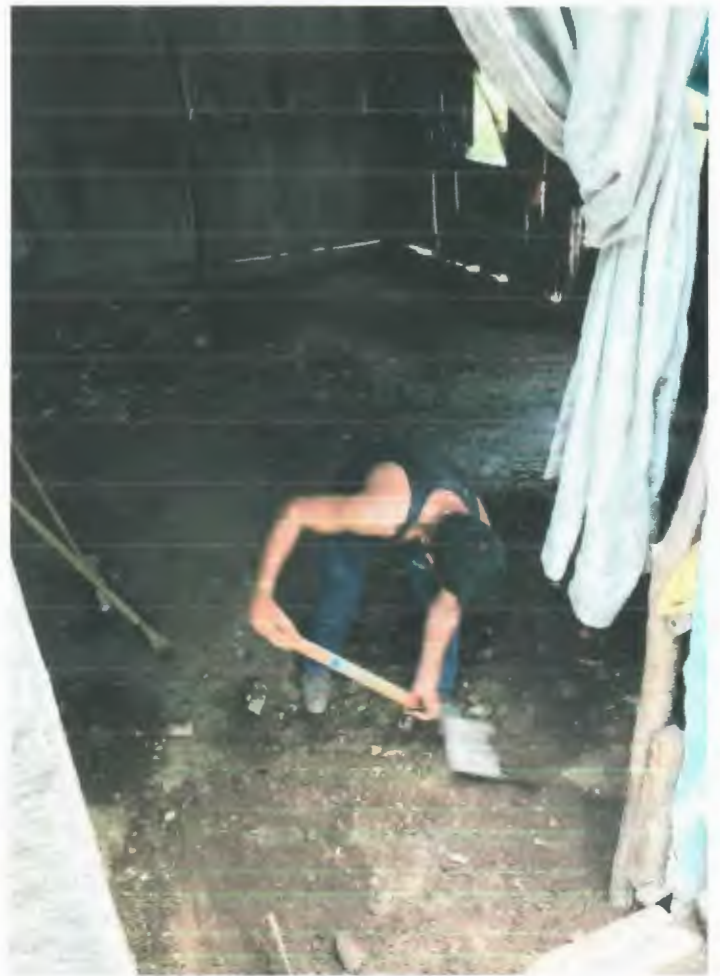
TRAZO Y NIVELACIÓN DE TERRENO PLANO POR MEDIOS MANUALES , RELLENO COMPACTADO CON PISON DE MANO EN CAPAS DE 20CM. UTILIZANDO MATERIAL DE BANCO
