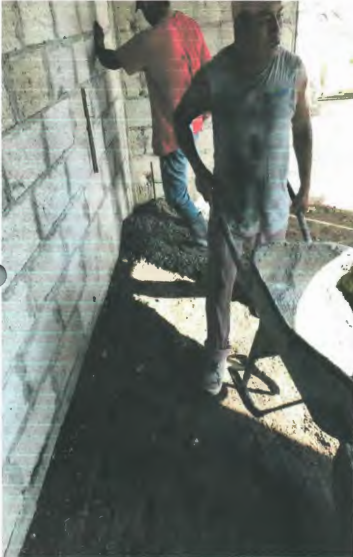
COLADO DE PISO DE 8 CM. DE ESPESOR DE CONCRETO HECHO EN OBRA F'C=150 KG/CM2, AGREGADO MAXIMO 3/4", ACABADO SEMIPULIDO
