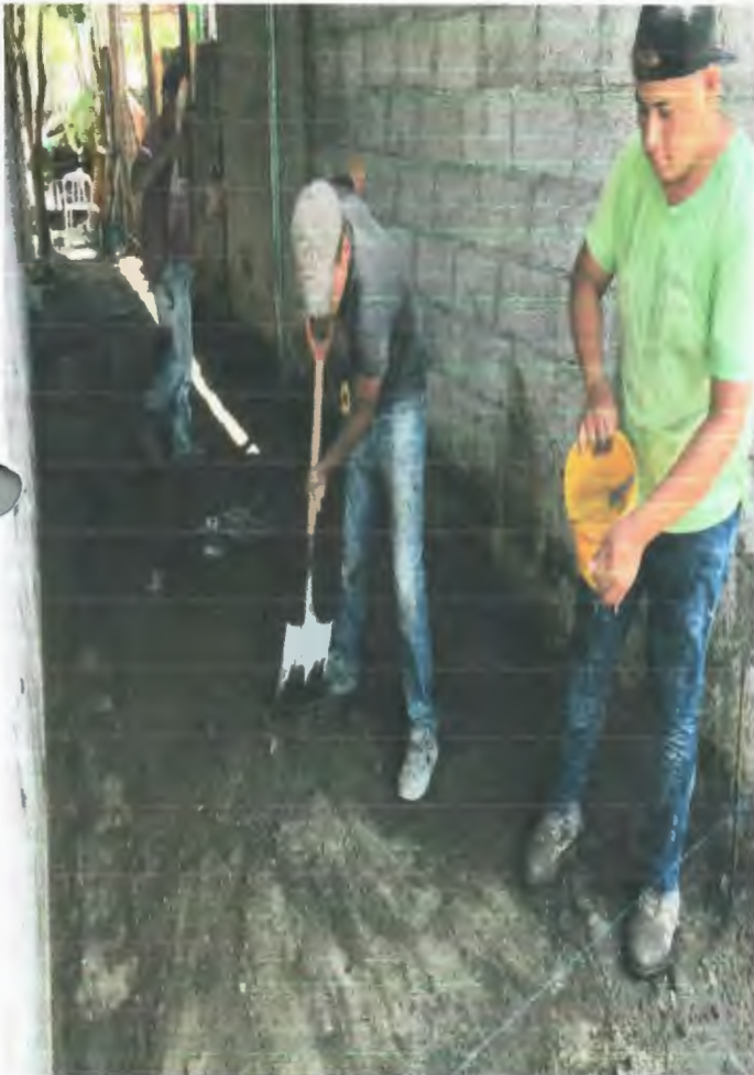
TRAZO Y NIVELACIÓN DE TERRENO PLANO POR MEDIOS MANUALES , RELLENO COMPACTADO CON PISON DE MANO EN CAPAS DE 20CM. UTILIZANDO MATERIAL DE BANCO
