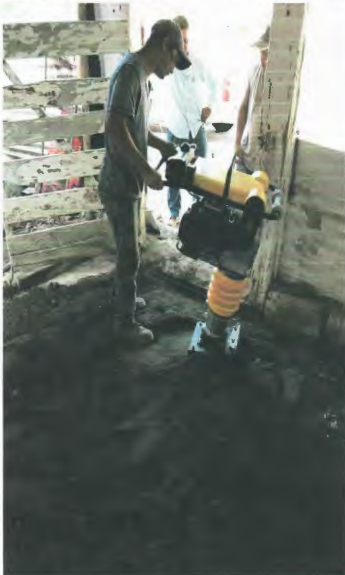
RELLENO COMPACTADO CON PISON DE MANO EN CAPAS DE 20CM. UTILIZANDO MATERIAL DE BANCO
