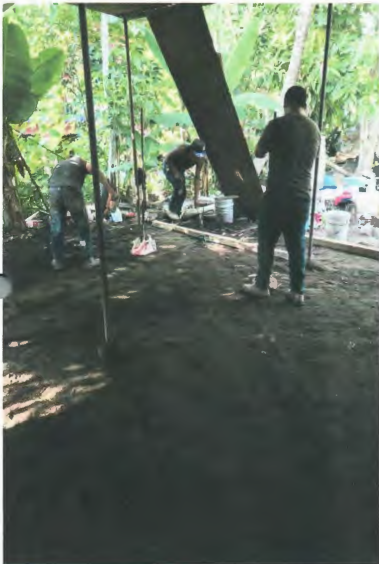
RELLENO COMPACTADO CON PISON DE MANO EN CAPAS DE 20CM. UTILIZANDO MATERIAL DE BANCO
