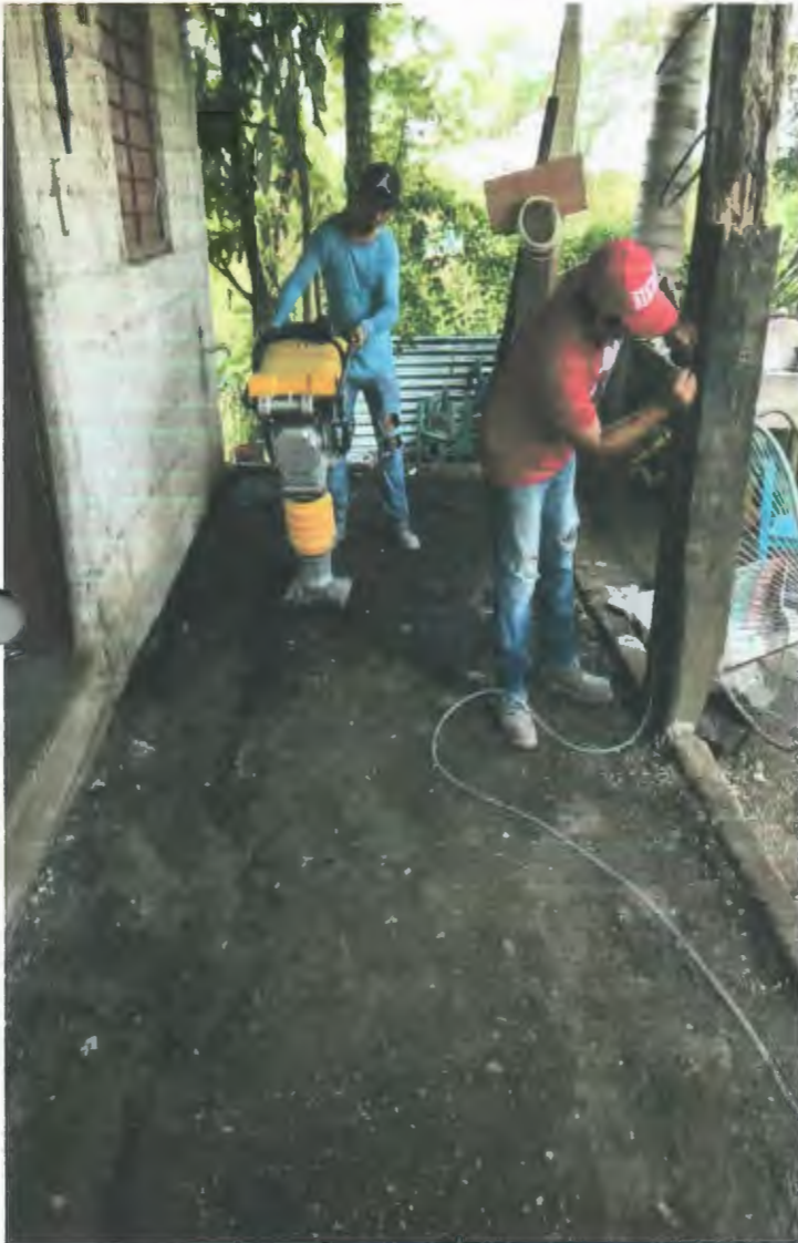
RELLENO COMPACTADO CON PISON DE MANO EN CAPAS DE 20CM. UTILIZANDO MATERIAL DE BANCO
