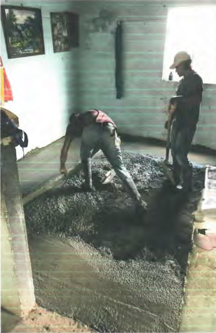
COLADO DE PISO DE 8 CM. DE ESPESOR DE CONCRETO HECHO EN OBRA F'C=150 KG/CM2, AGREGADO MAXIMO 3/4" DE DIAMETRO CONTROLADO
