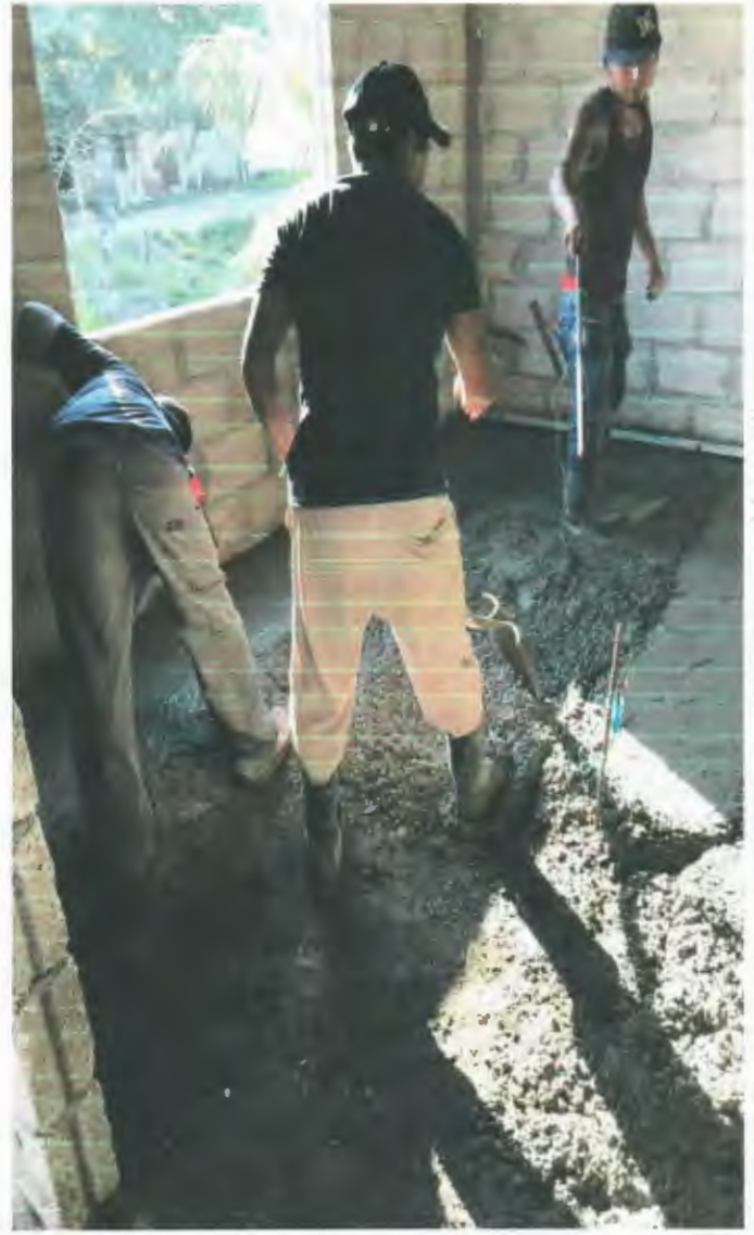
COLADO DE PISO DE 8 CM. DE ESPESOR DE CONCRETO HECHO EN OBRA F'C=150 KG/CM2, AGREGADO MAXIMO 3/4", ACABADO SEMIPULIDO
